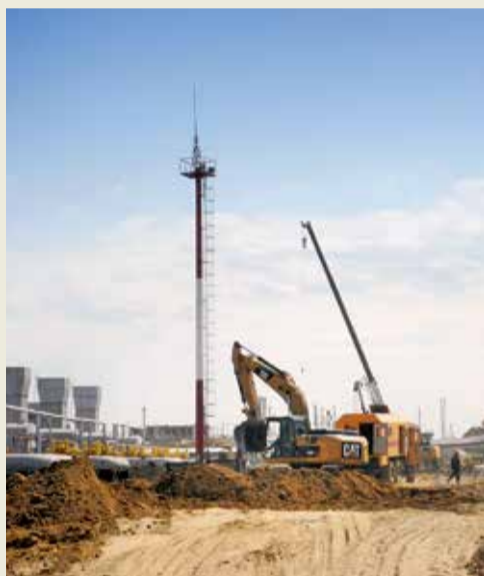
Место проведения работ
