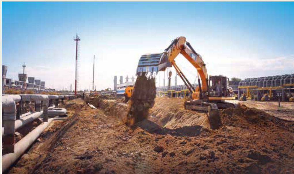
В комплексном ремонте задействована тяжелая техника
