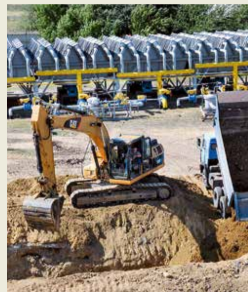
Завершающая стадия работ
