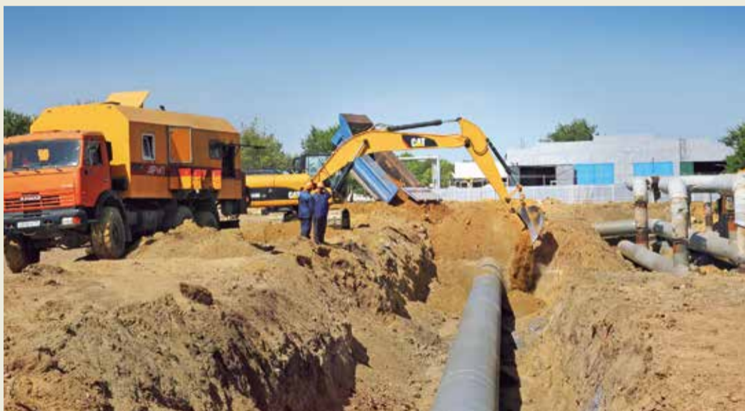
Обратная засыпка отремонтированного технологического трубопровода
