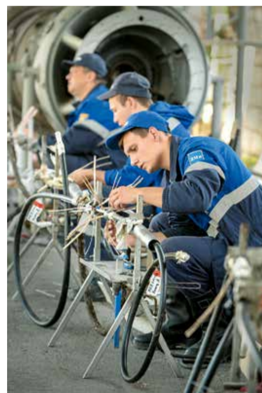
Монтаж жил кабеля
