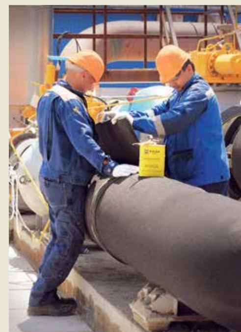
Изоляция трубопровода
