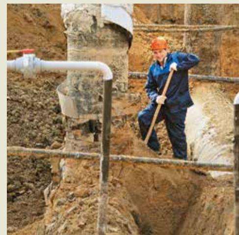
Снятие теплоизолирующего покрытия
