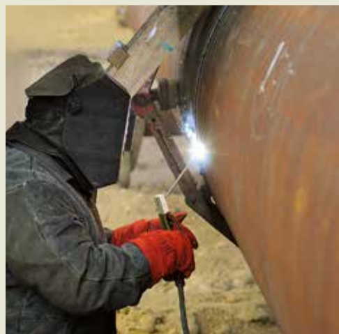
Сварка трубных заготовок
