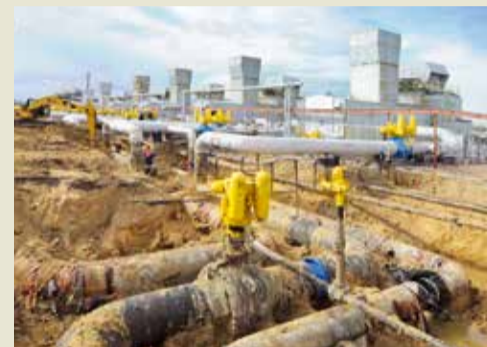
Подготовленные к ремонту коммуникации
