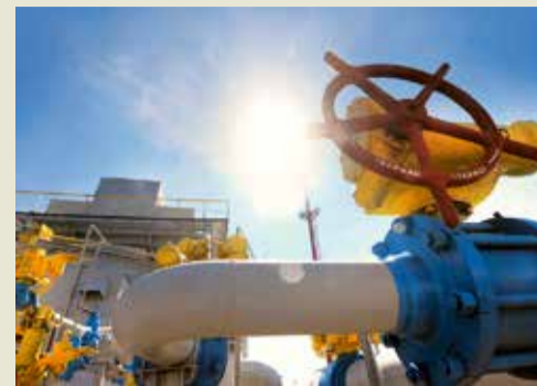
Отремонтированная обвязка ГПА
