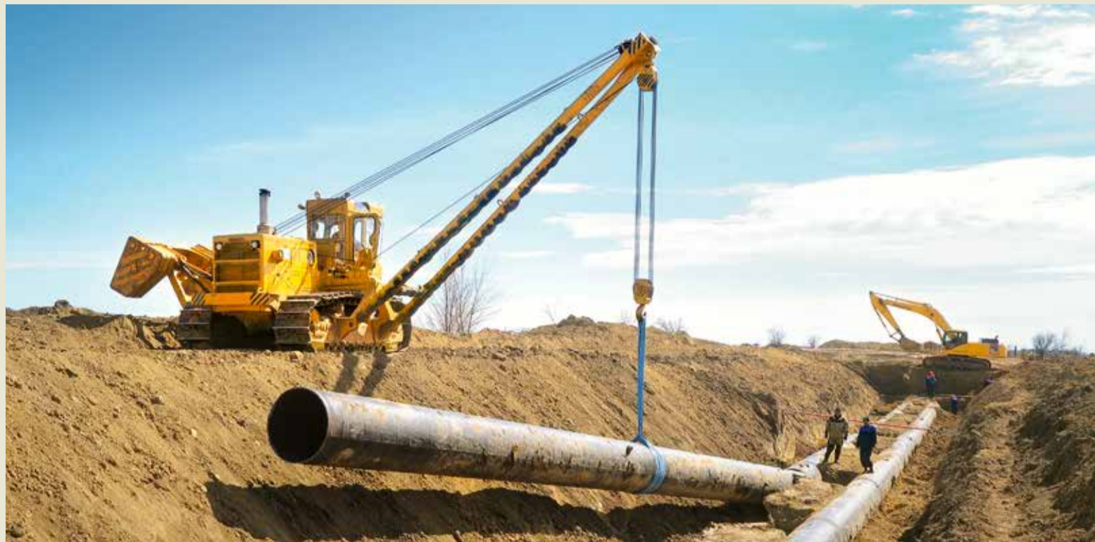
Демонтаж технологических коммуникаций для диагностического обследования трубы и нанесения изоляционного покрытия
