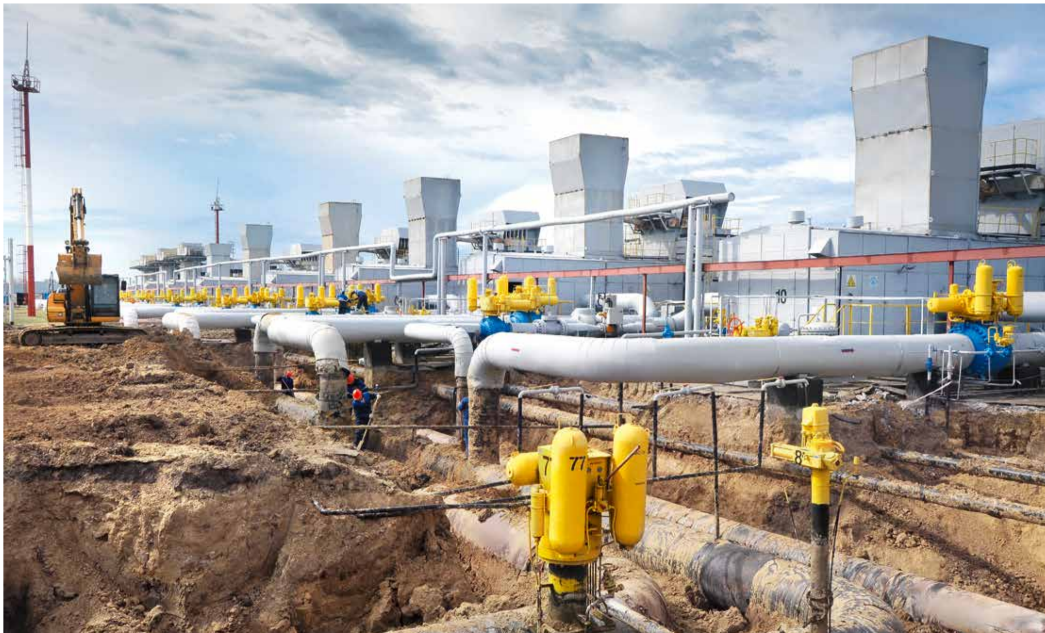
Работы по ремонту технологических трубопроводов второй ступени сжатия ДКС-2
