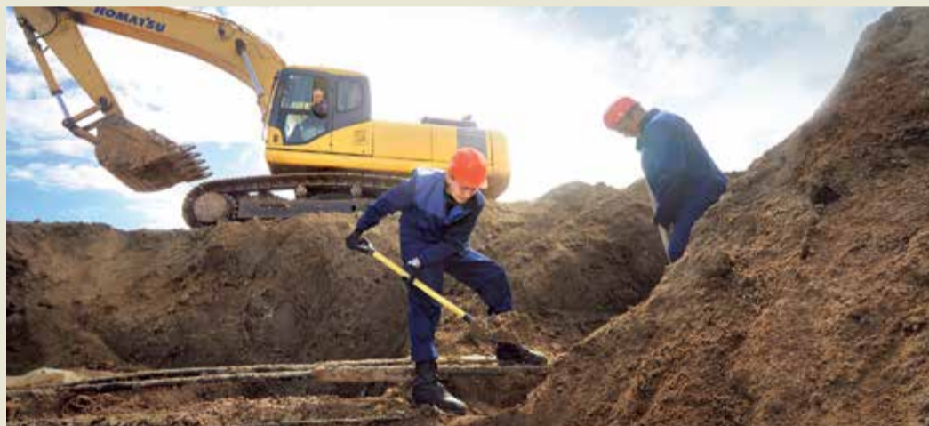
Ручная доработка грунта при вскрытии трубопроводов малых диаметров
