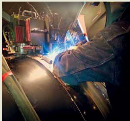
Сварка стыка
