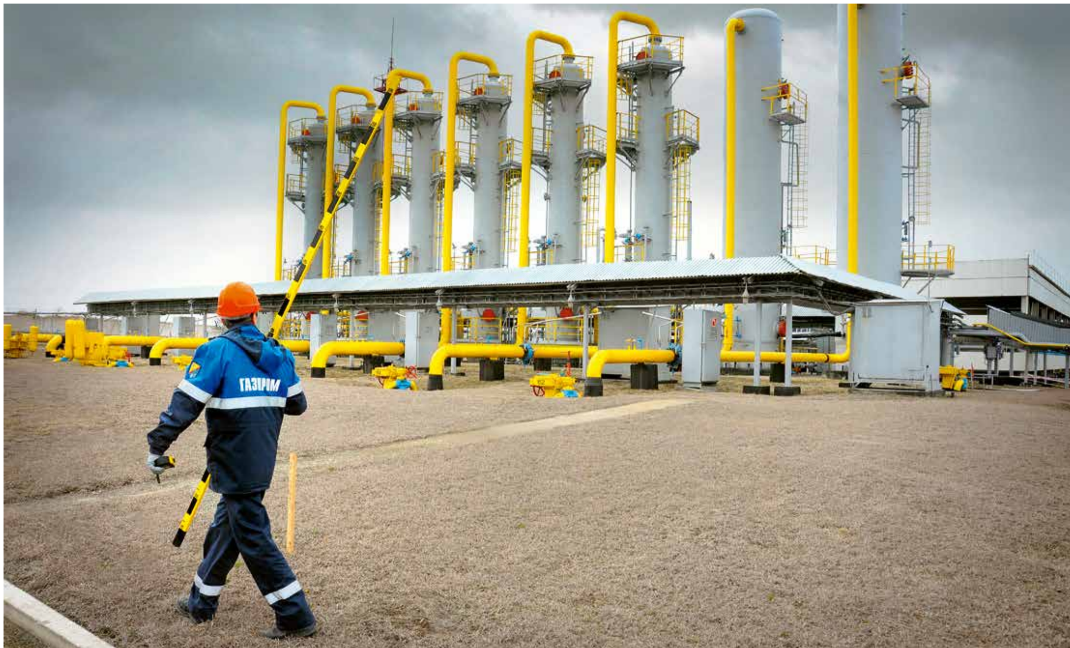
Подготовка к реконструкции установки осушки газа на ДКС-2
