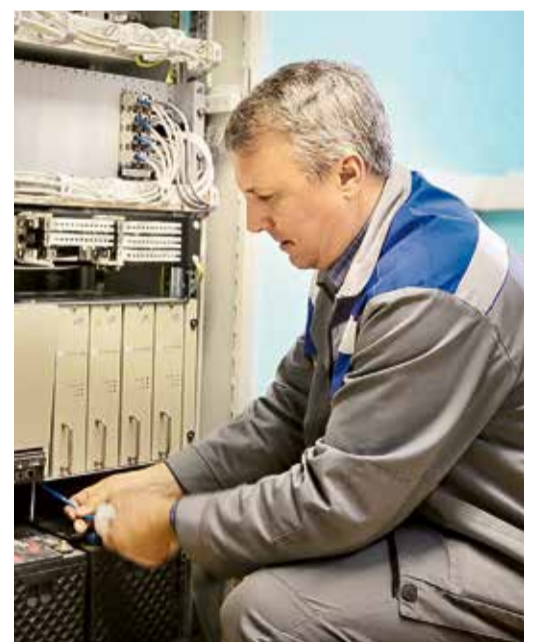
Монтаж оборудования радиорелейной линии
