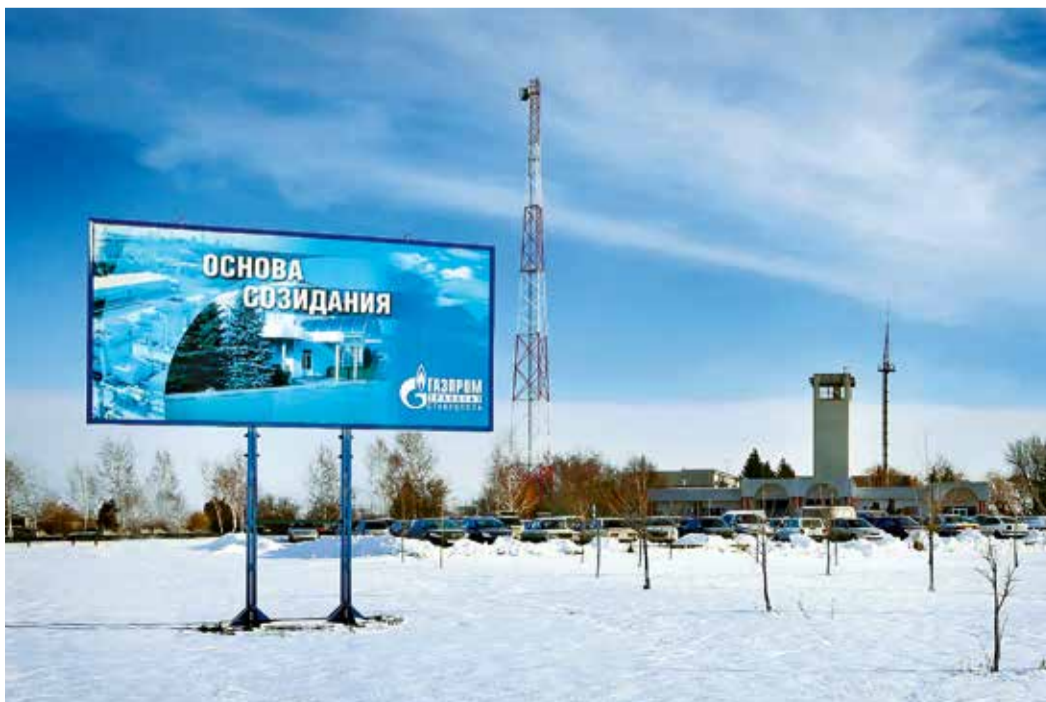
Новая башня радиорелейной линии связи МГ КС «Изобильный» – Невинномысск
