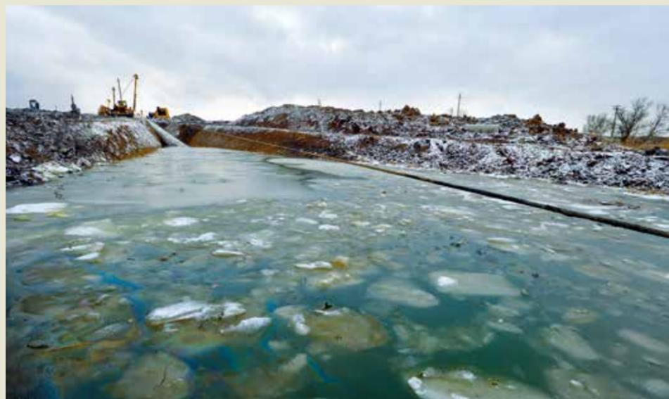
Протаскивание подводной части завершено. Осуществляется контроль глубины заложения
