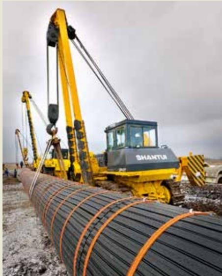
Газопровод защищен сборным футеровочным профилем
