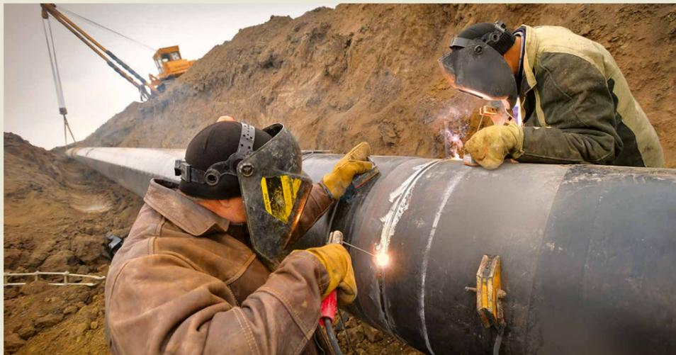
Подключение капитально отремонтированного участка газопровода
