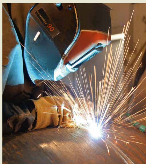
Сварка газопровода
