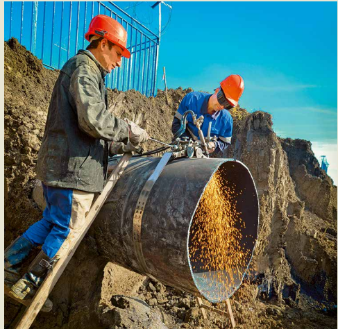
Машина газокислородной орбитальной резки в работе
