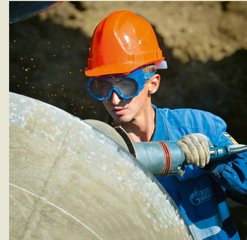
«Разделка» кромки для сварочных работ
