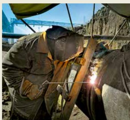
Сварка технической обвязки ГПА
