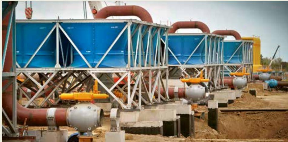
Монтаж аппарата воздушного охлаждения газа
