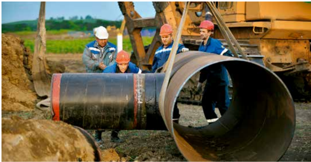
Подготовка тройника к врезке
