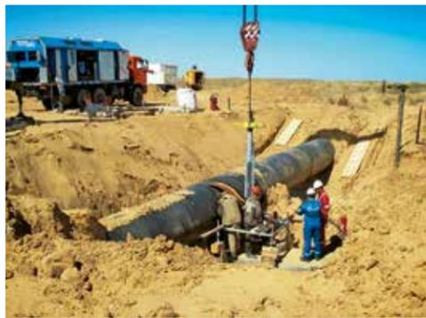
в нефтегазовой отрасли, – поясняет руководитель работ главный инженер Зензелинского ЛПУ МГ Василий Головатов, – и позволяет проводить замену дефектных участков трубопроводов, ремонт или установку задвижек, запорной арматуры без прекращения поставок газа и снижения рабочего давления в трубе. А это существенно экономит время проведения работ и минимизирует риски, связанные с поставками газа потребителям.
