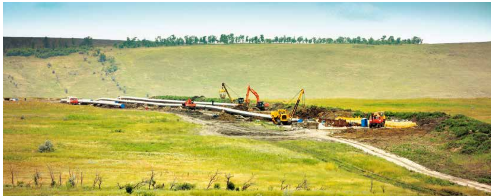
Место подготовки дюкера на четвертом оползневом участке трассы МГ КС «Изобильный» – Невинномысск
