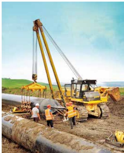
Подготовительные работы к протягиванию дюкера
