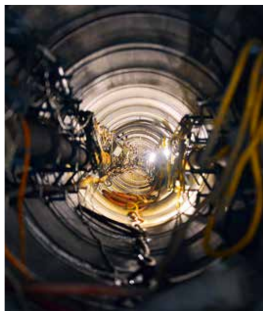
Общий вид тоннеля при проходке
