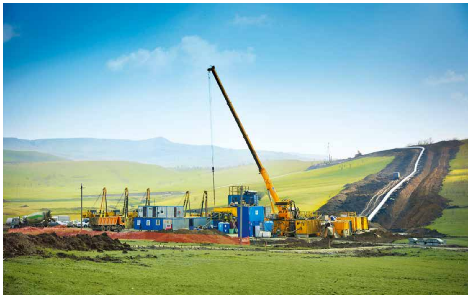
Площадка стартового котлована тоннелепроходческого комплекса строящегося газопровода КС «Изобильный» – Невинномысск
