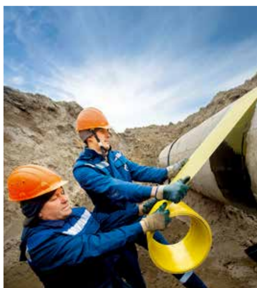
Установка муфты ГАРС
