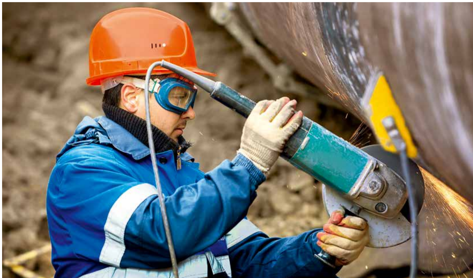
Обработка сварного стыка на 56-м километре МГ «Моздок – Невинномысск»
