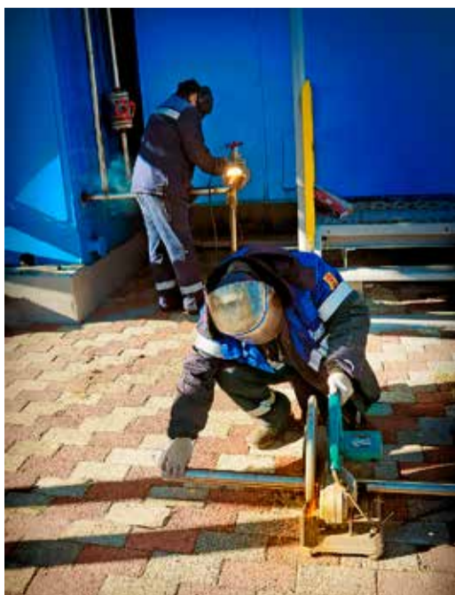
Подготовка к работам на КС-6
