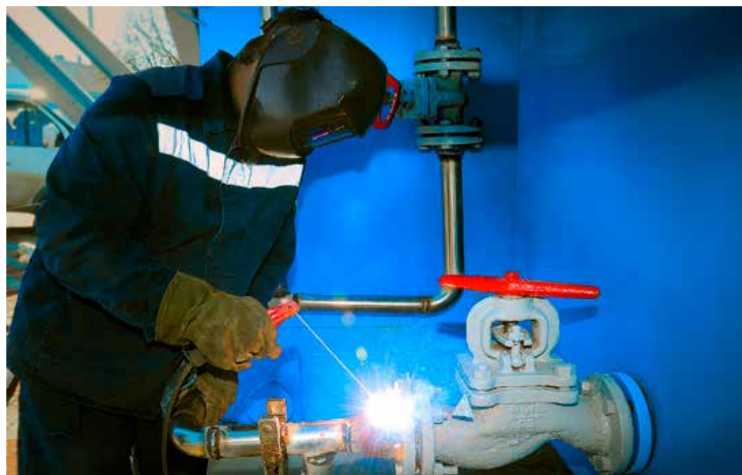
Монтаж системы циклового воздуха
