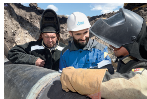
Проверка качества сварного соединения
