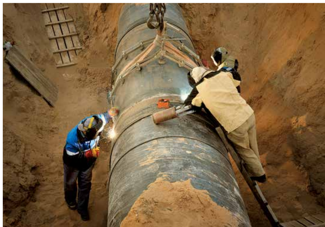
Сварка стыка
