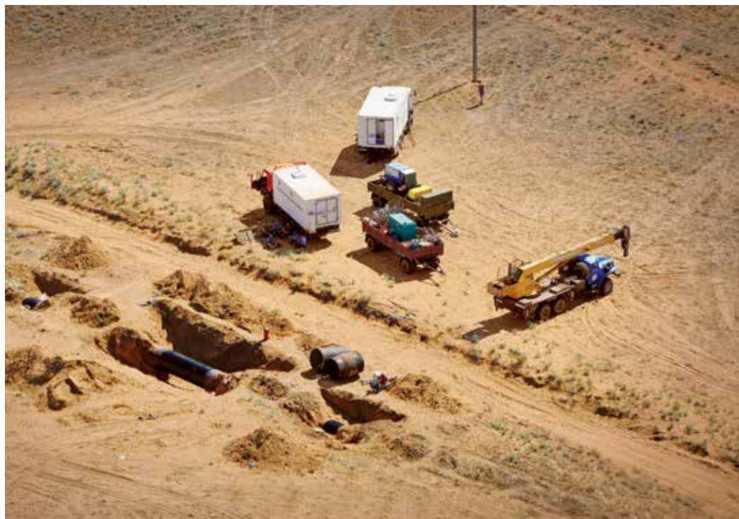
К производству работ готовы
