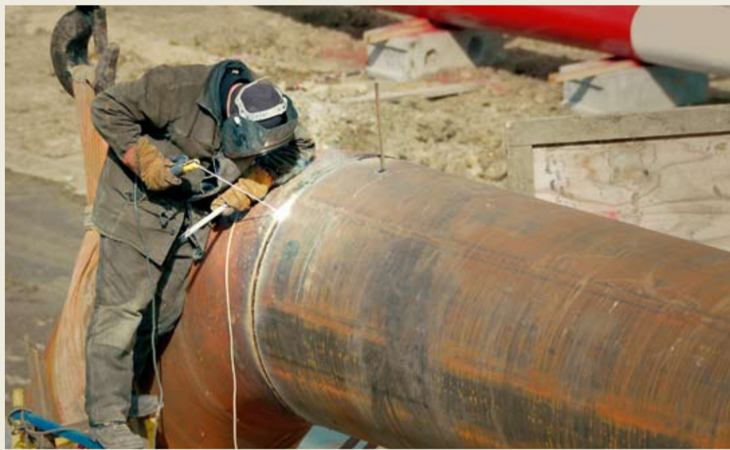
Сварка стыка
