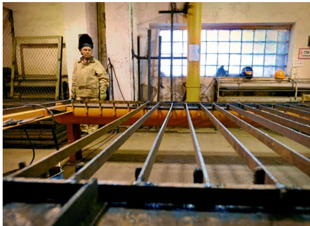
Изготовление конструкции ограждения
