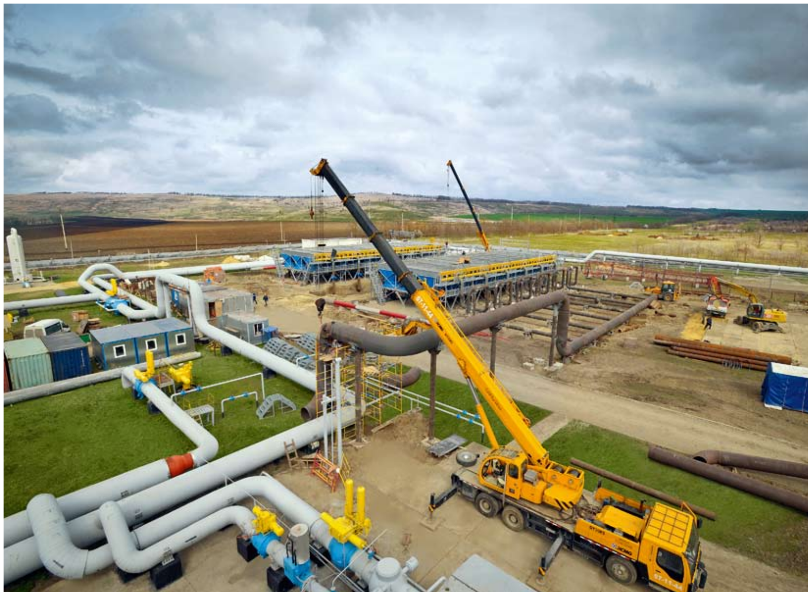
Работы по реконструкции технологического оборудования ДКС-1 Ставропольского ЛПУ МГ в самом разгаре
