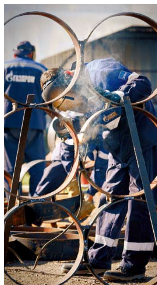
Сварка донных крепей
