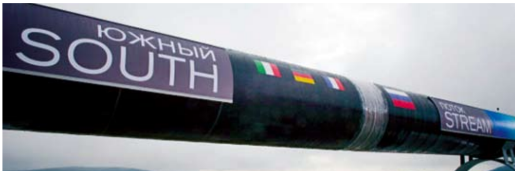
Сварен первый стык «Южного потока»
