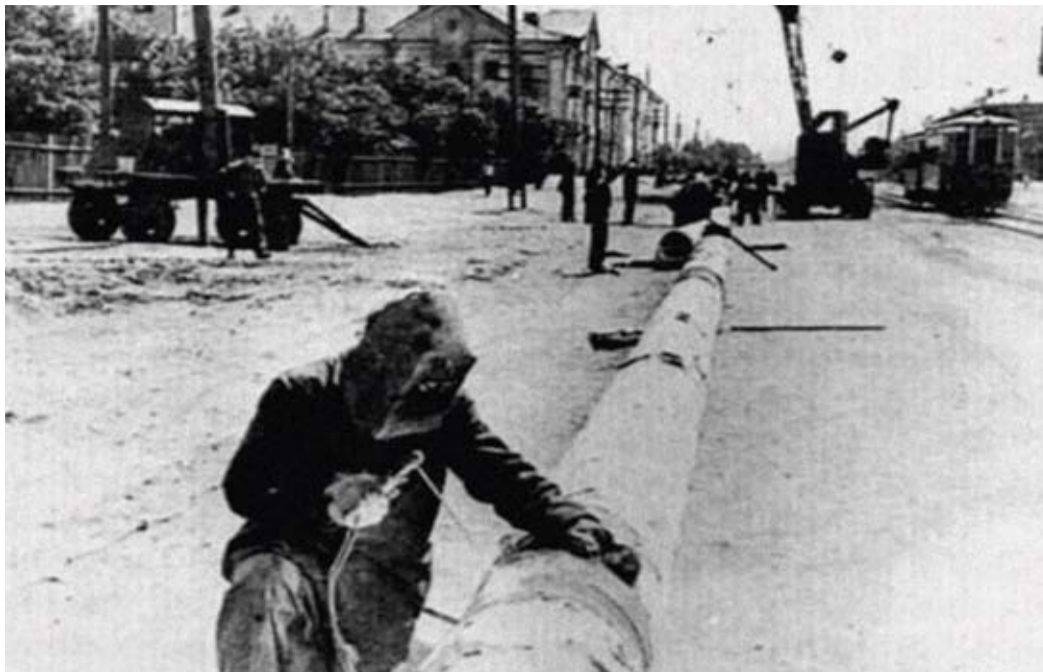
Сварка труб на газопроводе «Ставрополь – Москва», 1957 год
