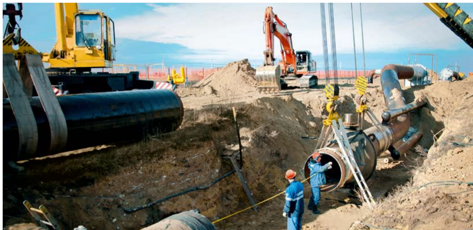
Работники ЛЭС готовятся к подключению камеры приема очистных устройств
