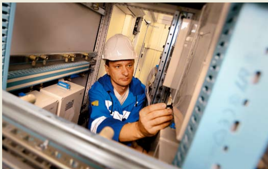
Настройка оборудования САУ ГРС
