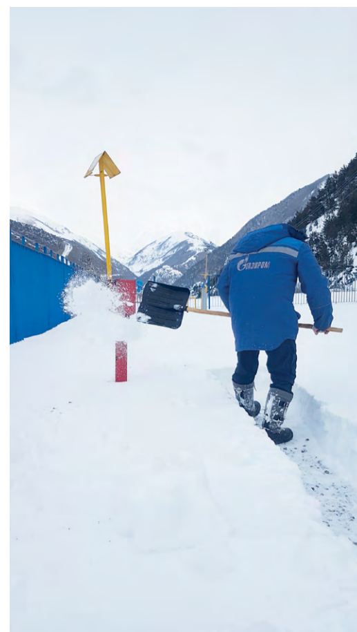
«Раскопки» кранового узла на 78 километре МГ Дзуарикау - Цхинвал
