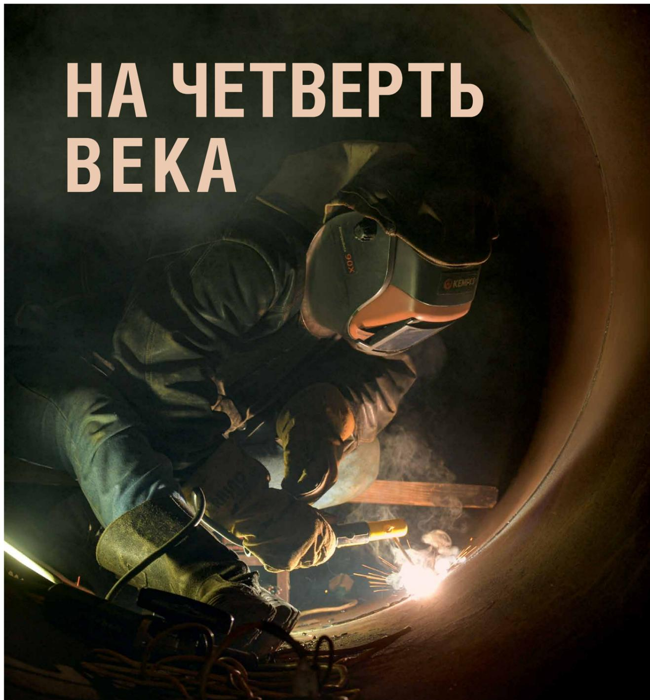
Сварка в нитку выполняется на выведенном в капремонт участке магистрального газопровода Новопсков — Аксай — Моздок. Следом за сварочным процессом ведется изоляция восстановленной трубы и укладка газовой магистрали в траншею с последующей засыпкой.
