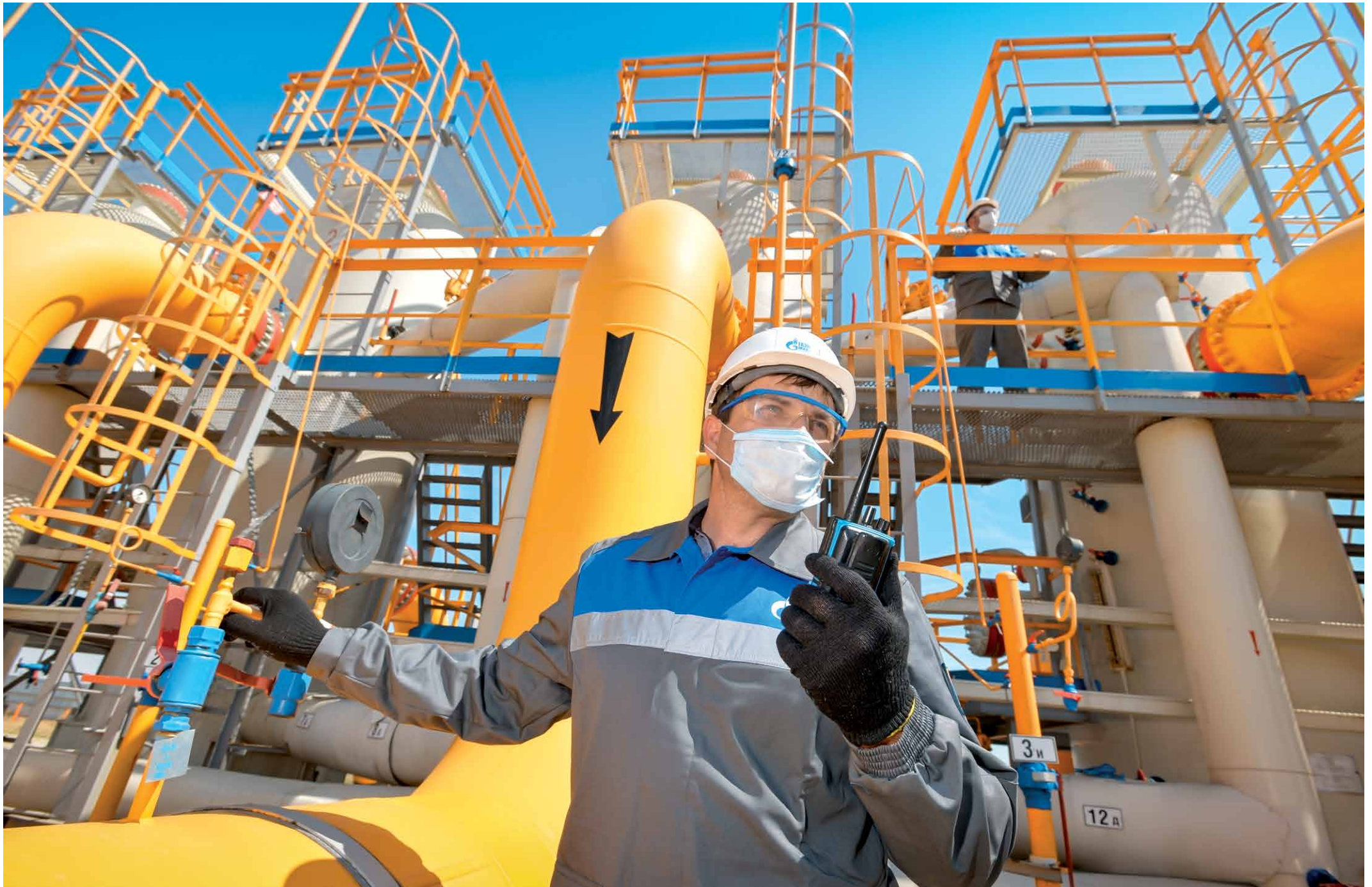
На КС «Сальская» полным ходом идут ремонтные работы. Подробности читайте на 4-й полосе
