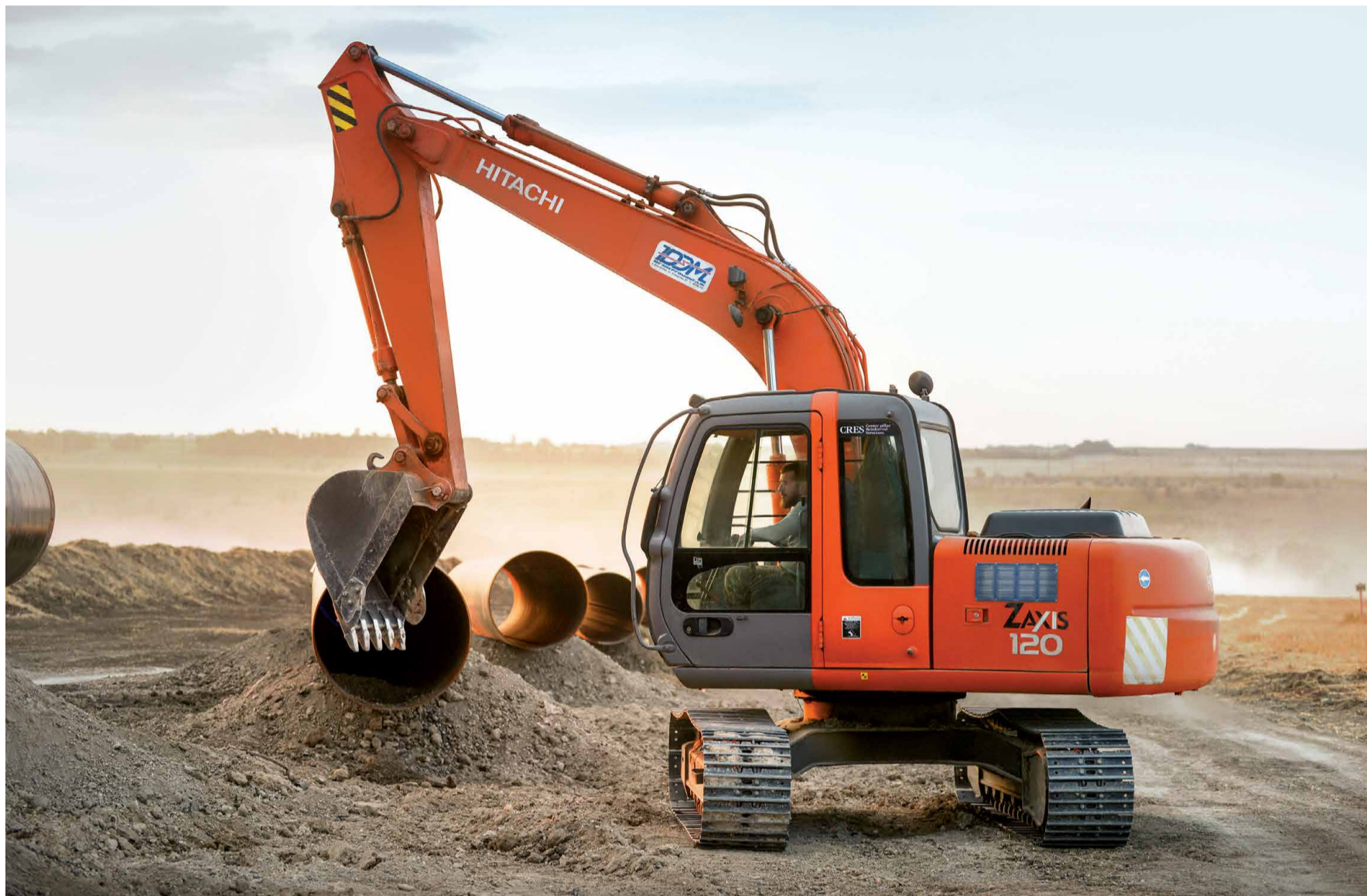
Теплое время года — всегда напряженный период для газовиков. После окончания отопительного сезона «дэсовцы» приступают к активным работам на газовых трассах. Обследуют, ремонтируют и обновляют газопроводы, обеспечивая надежность эксплуатации газотранспортной системы. Летняя пора позволяет газовикам основательно подготовиться к новому осенне-зимнему сезону и без перебоев снабжать голубым топливом потребителей в холодное время года.
