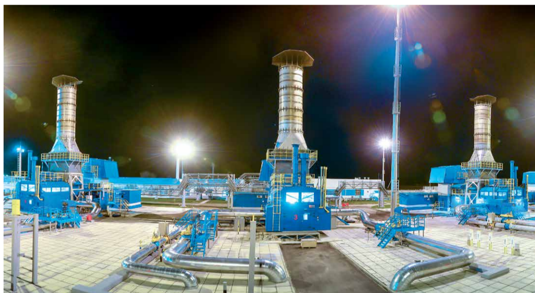
В сжатые сроки специалисты службы отремонтировали концевую муфту кабельной линии на КТП-1 КС «Георгиевская»
