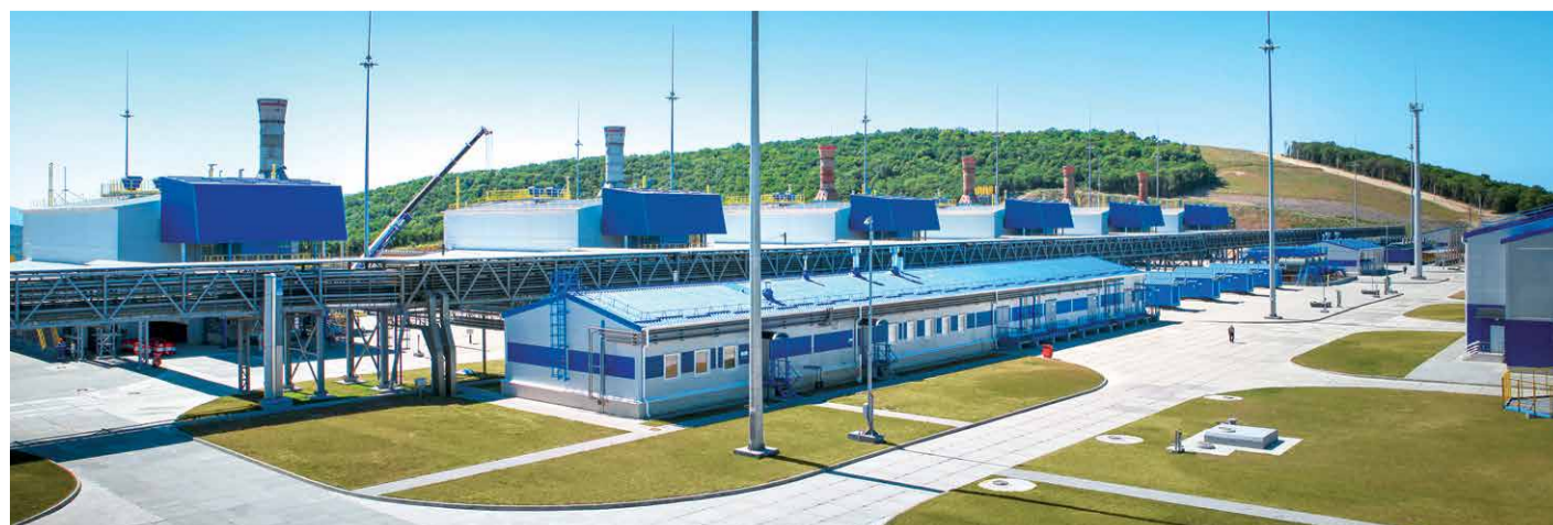
Компрессорная станция «Русская»
