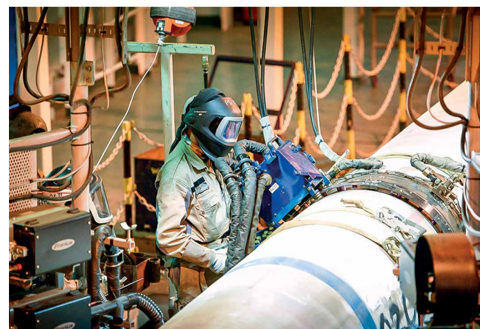
Сварка трубы на борту строительного судна Pioneering Spirit
