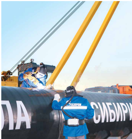
Сварка стыка
